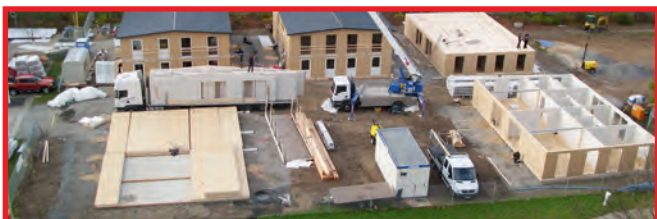
Bau der Gemeinschaftsunterkunft Würzburg Zellerau 2015, Foto: Staatliches Bauamt Würzburg
