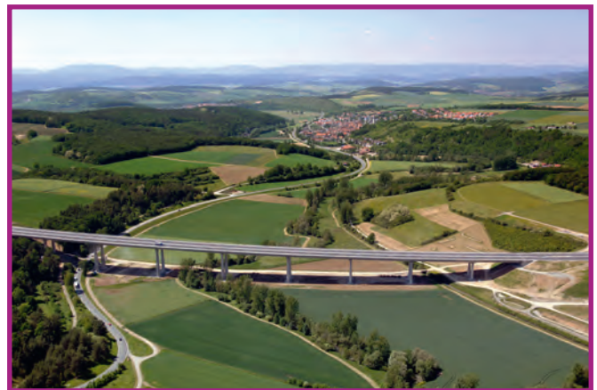
Saaletalbrücke Foto: Hajo Dietz, Nürnberg Luftbild
