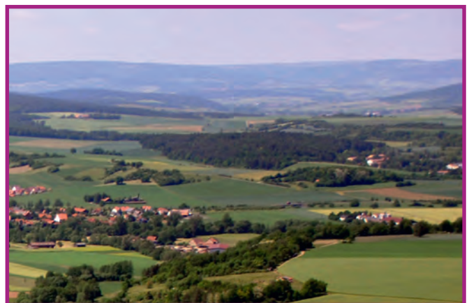
Bahratalbrücke Foto: Hajo Dietz, Nürnberg Luftbild
